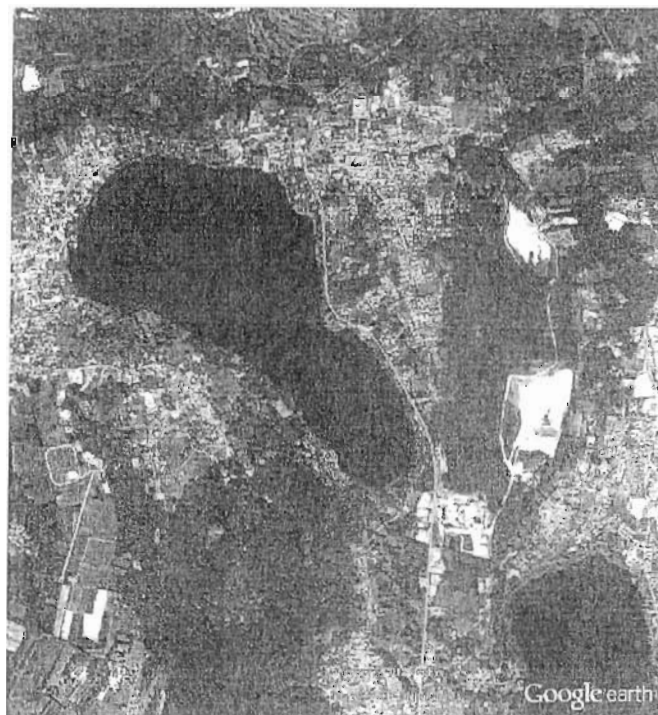
Figura 1. Il Lago di Monate (provenienza: Google Earth). Sono visibili le cave di Santa Maria e Faraona.
